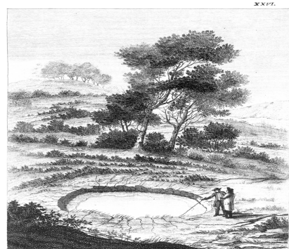
Suolo avvallato a forma quasi circolare nel distretto delle contrade di S. Spiridione in Calabria, e tipo di sprofondamento
